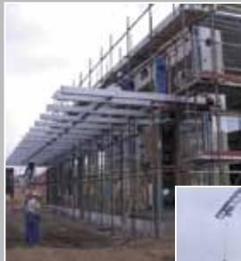
Varjena jeklena konstrukcija fasade in nadstreška.
