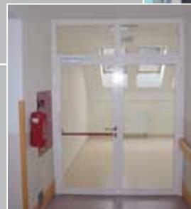
Protipožarna vrata s stekлом, odpornost e 30, opremljena s samozapiralom in zračnikom.
