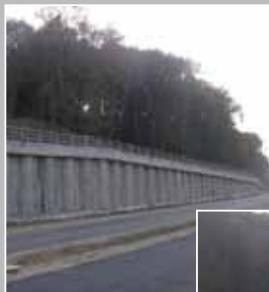
Varovalne cevne ograje na opornih zidovih in prepustih.
