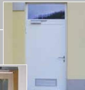
Protipožarna vrata s stekлом in polnilom, odpornost e 30, opremljena z avtomatskim odpiranjem.
