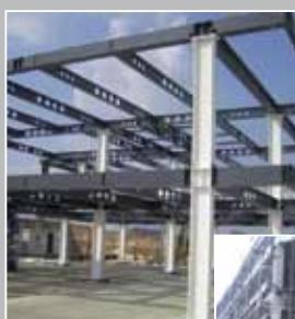
Vijačna jeklena konstrukcija za nadvišanje dveh etaž ter pritrditev fasade in kritine.
