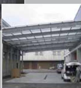
Vijačna vroče cinkana jeklena konstrukcija - nadstrešek z polikarbonatno kritino
