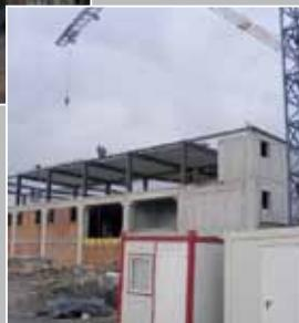
Vijačna jeklena konstrukcija za nadvišanje etaže in pritrditev kritine.
