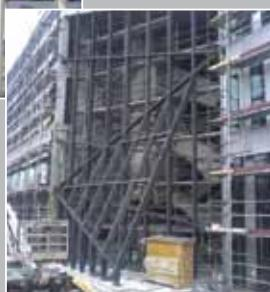
Varjena jeklena konstrukcija - vhodni fasadni del z nadstreškom.
