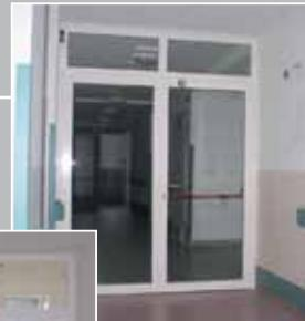
Protipožarna vrata s stekлом, odpornost ei60, opremljena s panik drogom.
