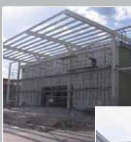
Vijačna jeklena konstrukcija - vhodni nadstrešek in podkonstrukcija fasade.
