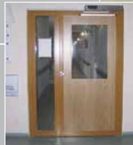
Protipožarna enokrilna vrata s polnilom, odpornost ei 30, standardne dimenziije: 800,900,1000 x 2050 ali 2150mm.
